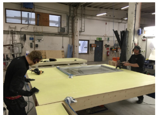
图 24 非承重木骨架节能墙体的工厂预制
