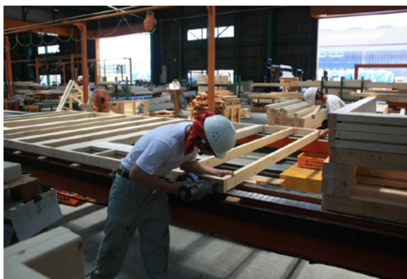
图 23 非承重木骨架节能墙体的工厂预制
