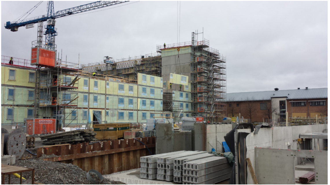
图 25 混凝土结构 + 预制木骨架非承重墙体
