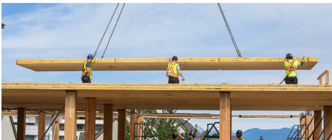
图 9 CLT 楼板的吊装
