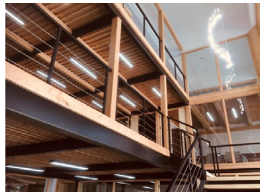
图 20 钢木混合结构办公室
