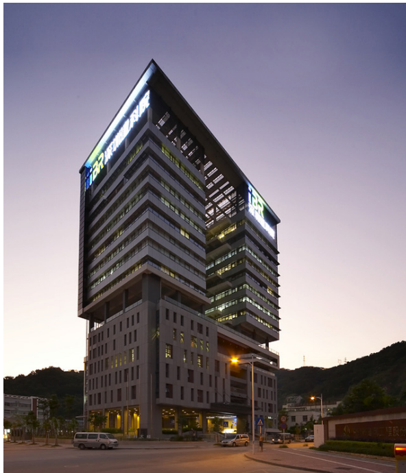
图 28：深圳市建筑科学研究院大楼的照片
