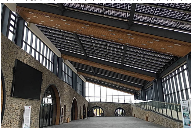
图 35 光伏屋面一体化，安吉县鄞吴镇游客中心，浙江省
