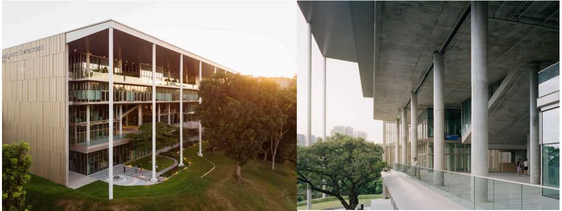
图 14：新加坡国立大学设计与环境学院使用巨大的挑檐进行遮阳
