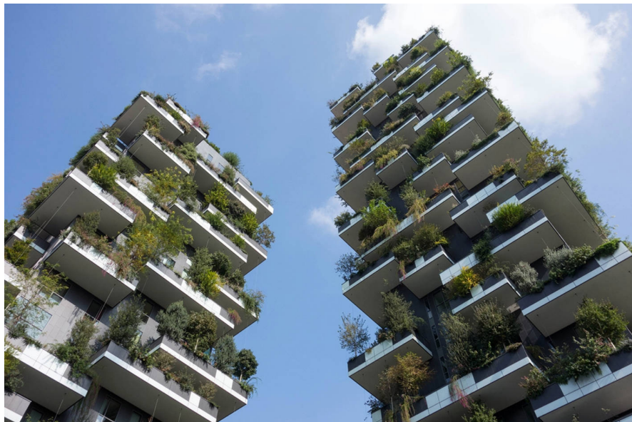
图 13：位于意大利米兰 Bosco Verticale 住宅项目采用自遮阳策略，建筑通过挑出的阳台为下方的门窗洞口提供遮阳
