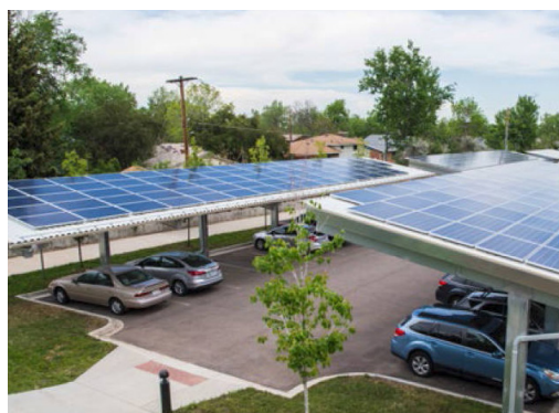
图 37: 光伏发电与停车位相结合
